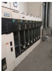
Création des ouvertures
