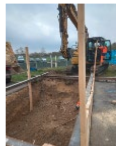
Remblaiement de la fouille et reprise de l'enrobé
