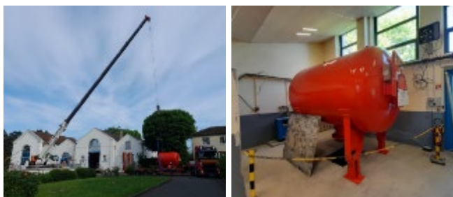
Compresseur/Filtre et coffret électrique (hors crue 1910 + 1m)
