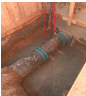
Mise en évidence de la conduite et des raccords et réparation
