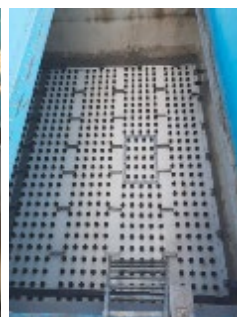
Mise en place du plancher
