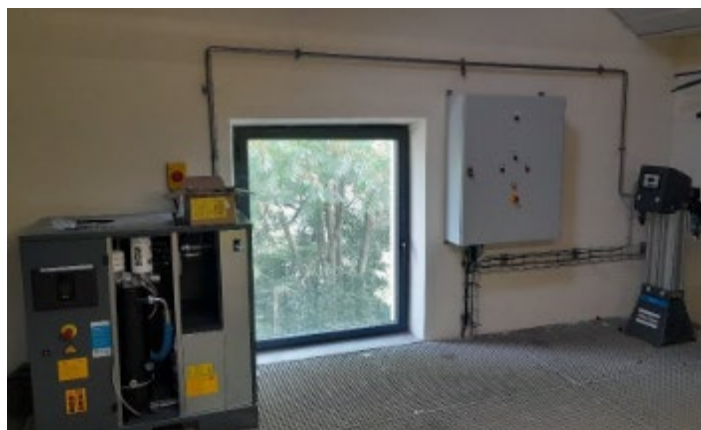
Compresseur/Filtre et coffret électrique (hors crue 1910 + 1m)
