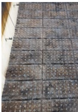
Démontage des joints de plaques
