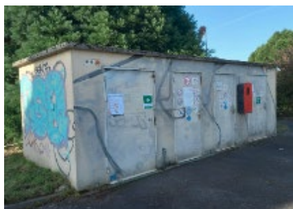
Local chlore avant
