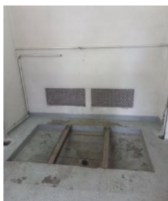
Réalisation de carottages
