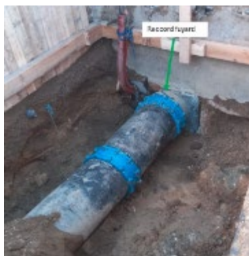
Mise en évidence de la conduite et des raccords et réparation
