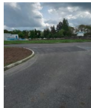
Remblaiement de la fouille et reprise de l'enrobé
