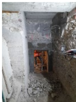
Travaux de génie civil, ouverture des trémies
