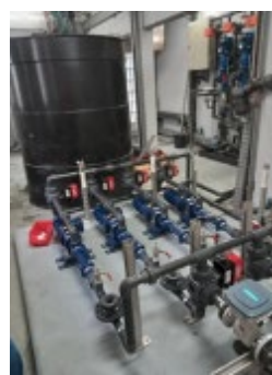
Nouvelle installation de dosage
