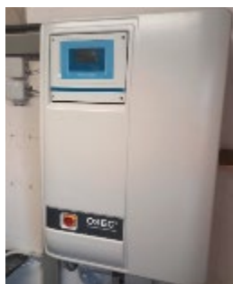
Electrolyseur
