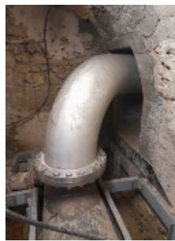
Mise en place du piquage et de la vanne d'isolement
