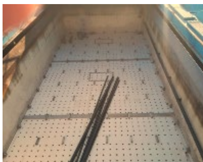
Mise en place du plancher
